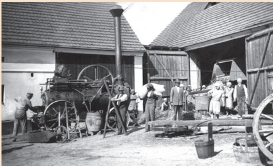
MLÁCENÍ U KÖNIGSMARKŮ. UPROSTŘED SNÍMKU VE SPODNÍ ČÁSTI JE VIDĚT ŽENTOUR, POUŽÍVANÝ K POHONU STROJŮ ZA VYUŽITÍ KOŇSKÉHO POTAHU. VPRAVO DOLE JSOU PROTIPOŽÁRNÍ NÁDOBY – PUTNA A ŠKOPEK.
